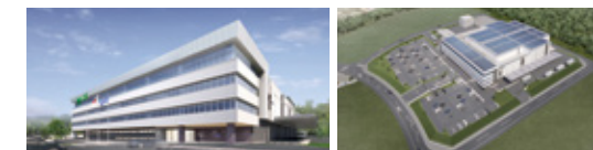
新工場:各務山工場(左:正面 右:全体)
